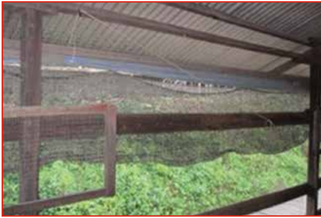
Figura 24: Ejemplo de la malla negra en las paredes laterales de un galpón abierto.
