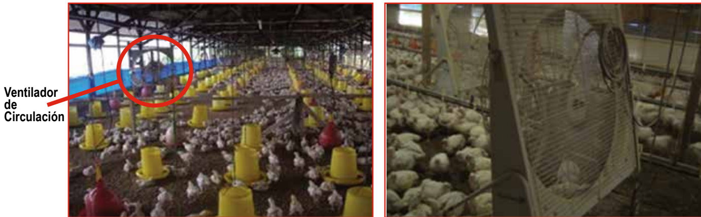
Figura 28: Ejemplo de ventiladores de circulación. Un ventilador suspendido en la imagen izquierda, y uno de piso en la imagen derecha.
