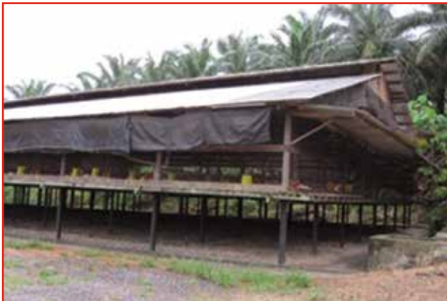
Figura 23: Salientes/aleros del techo extendidos y paredes laterales cubiertas con malla para dar sombra.
